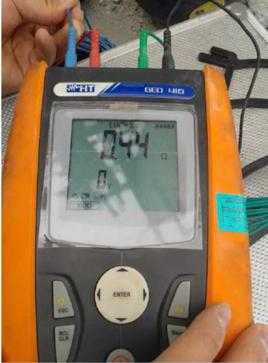
Resim2: Elektrik bakıma ait topraklama
